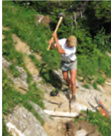
Holzstufen, mit Erde hinterfüllt (links).
