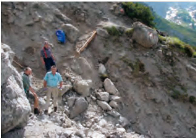
Gegen die Erosion an den hangseitigen Wegrändern schützt der Einbau seitlicher Befestigungen, zum Beispiel mit Rundhölzern oder Brettern, wie an diesem steilen Schutthang.
