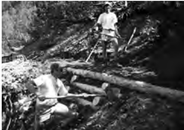
Wegbefestigung mit Rundholz und Hinterfüllung mit Umgebungs- material.
