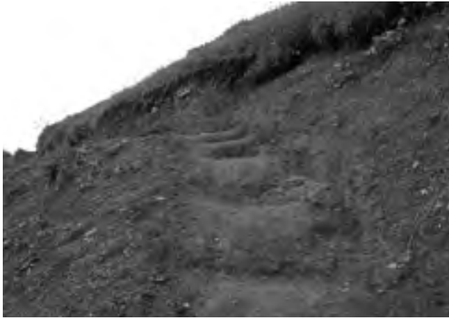
Erdstufen: nur eine kurzfristige Übergangslösung.
