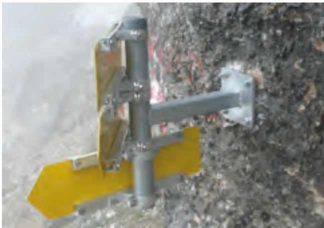
Eine selbst angefertigte Befestigung an einer Felswand.
