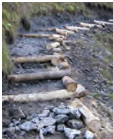
Stufen auf Längsträgern (links).
