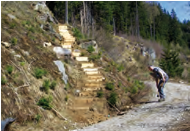
Neubau von Holzstufen mit Hinterfüllung.
