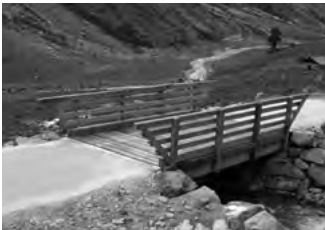
Eine befahrbare Brücke.
