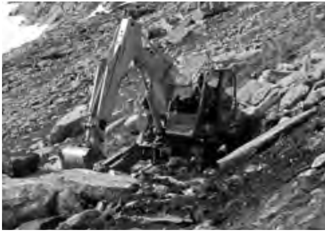
Schichtung von Gneisplatten und Füllung mit sandigem Material.
