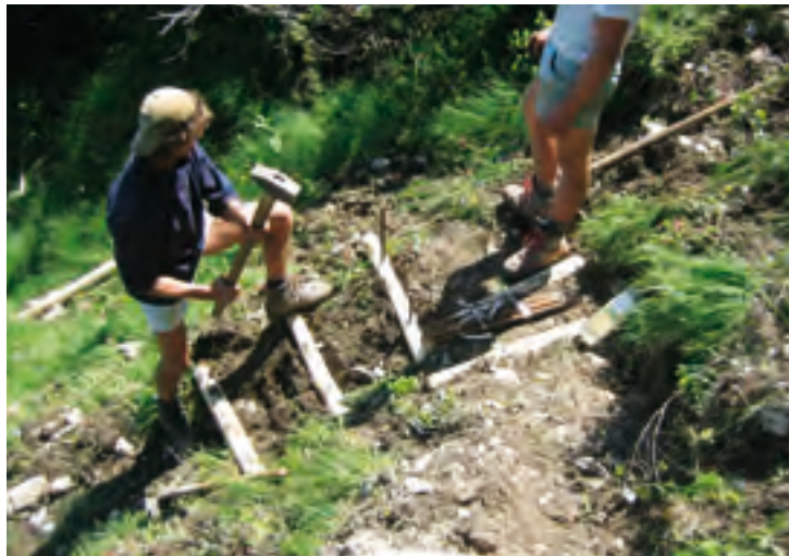
Einbau von Holzprügelstufen.
