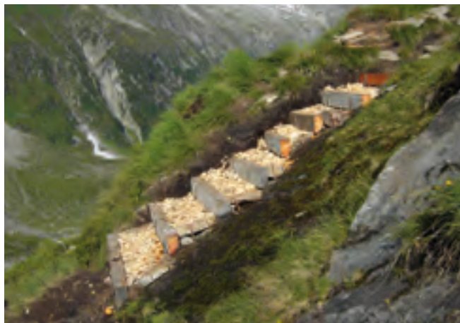
Stufen, mit Hackschnitzeln verfüllt.
