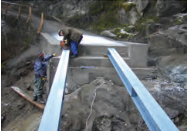
Einbau von Stahlträgern.
