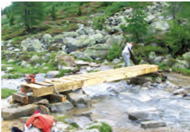
Neubau einer Holzbrücke.
