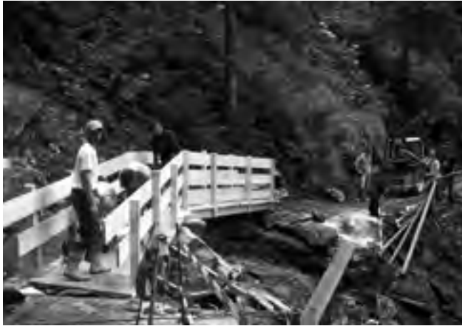
Brückenkonstruktion aus Holz.
