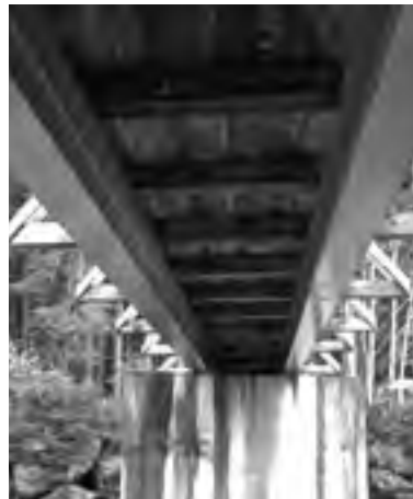
Unterbau Baumstamm (links).
