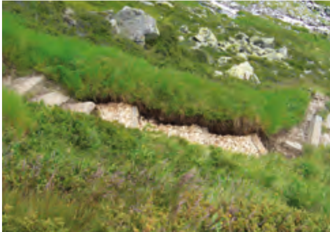
Mit Hackschnitzeln verfüllte Treppe.
