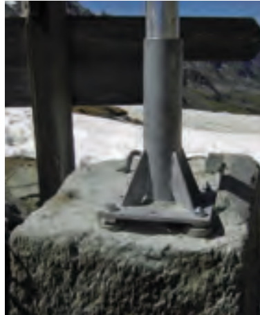
Rohrsteher in einem Metallschuh auf einer Felsplatte (links).
