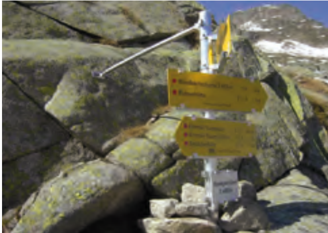
Ein kurzer Rohrsteher aus Aluminium mit einer zusätzlichen Abstützung.
