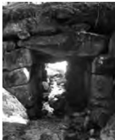
Bachdurchlass mit einem Rohr (links).
