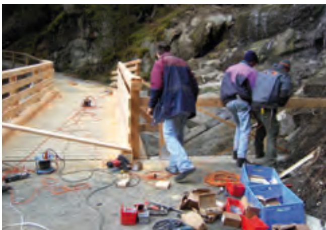
Montagearbeiten beim Bau einer Holzbrücke.
