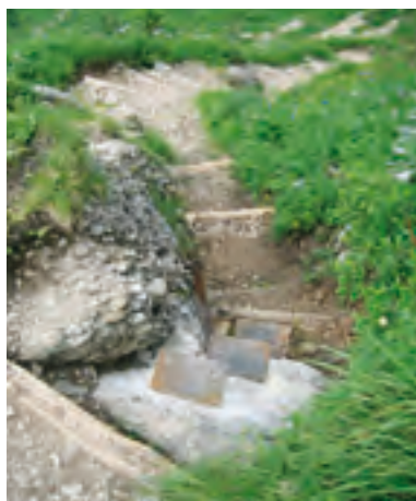
Treppe aus Stufen und Eisenritten.
