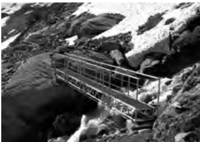
Brückenkonstruktion aus Gerüstbauteilen und Betonfundamenten.
